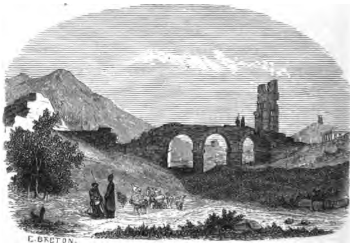
Pont du Stade en 1750.
